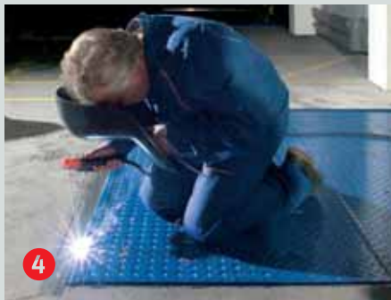
Przyspawanie do kątowników krawędziowych. Gotowe!
